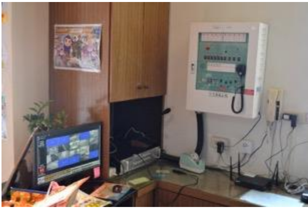
圖105 火災警報及監視系統
