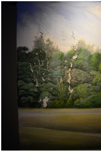
圖5 第一館漏水痕跡
