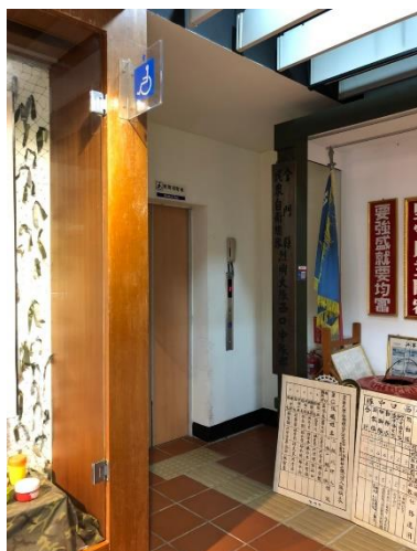
圖254. 烈嶼鄉文化館電梯
