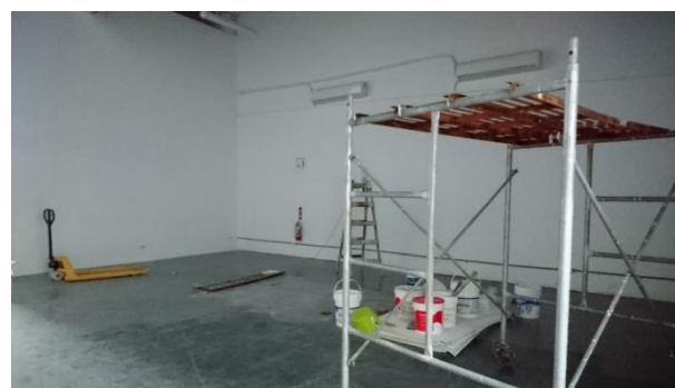
圖119. 入口處預留工作間（工程進行中）
